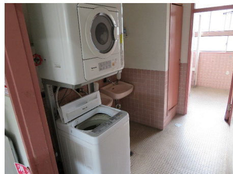
洗濯機・乾燥機
